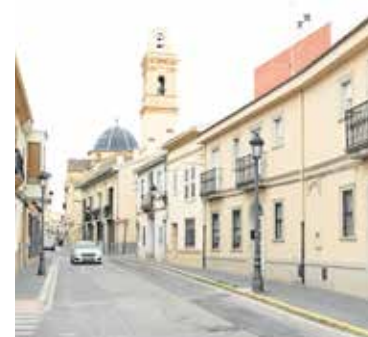
GODELLA REASFALTAT DEL CARRER MAJOR
