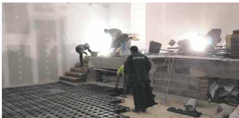
► Obres al Llar
