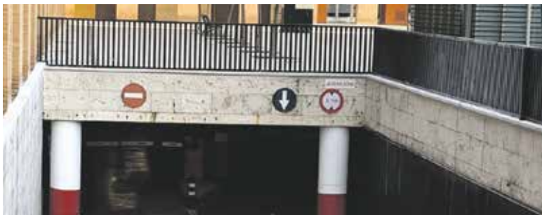
► Entrada al pàrquing
