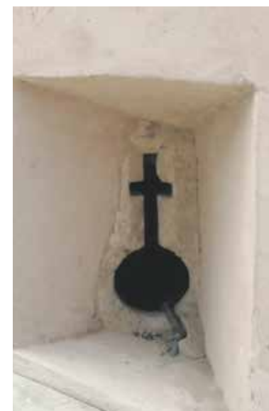
► Detalle de aspilleras para armas de fuego al tratarse de un señorío fortificado
