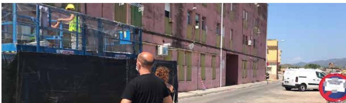
El alcalde y la concejala visitan las obras
