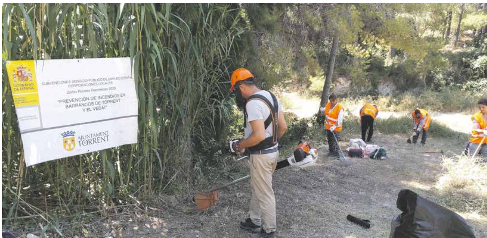
Labores de limpieza en el Vedat
