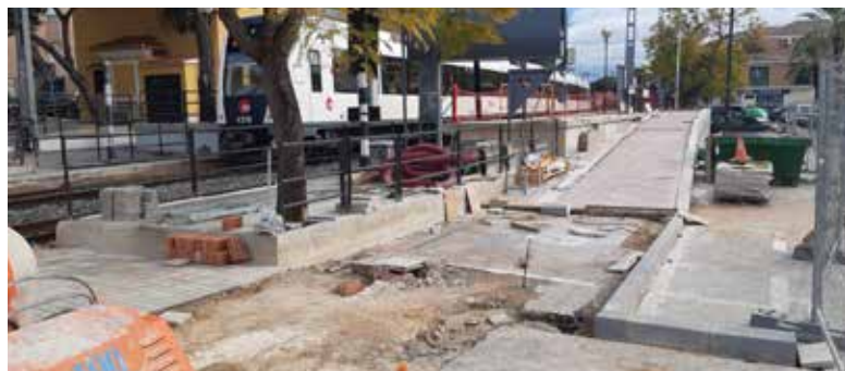
Obras en la estación de La Canyada
