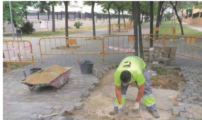
Obres a la via pública
