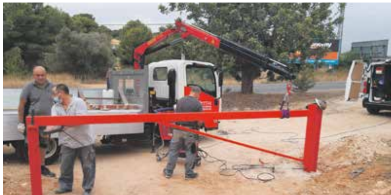
Instal·lació de barreres
