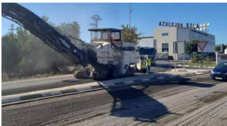
Obres de remodelació
