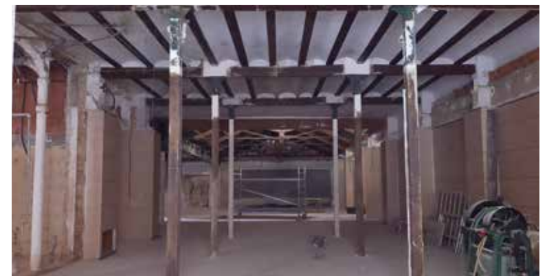
Edifici Serveis Socials
