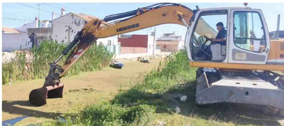
Màquina treballant en la zona
