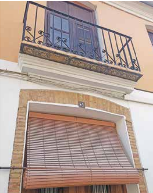
Detalls en la façana dels habitatges
