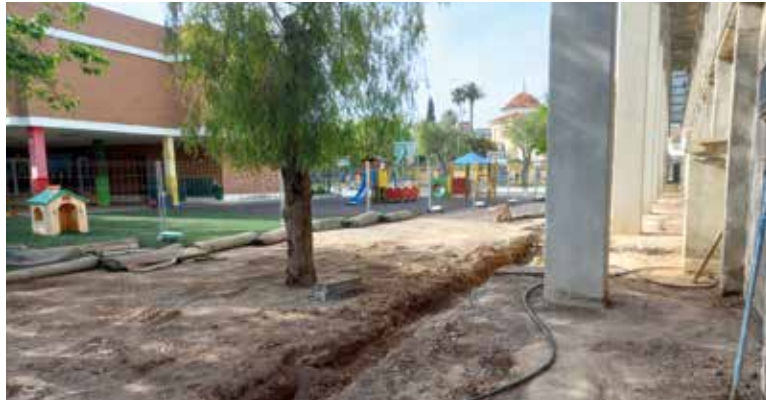
Obres al CEIP
