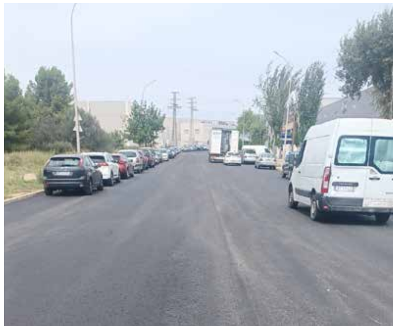
Obres al polígon
