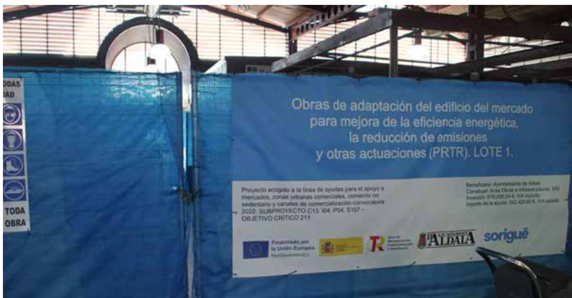
Obres al Mercat Municipal
