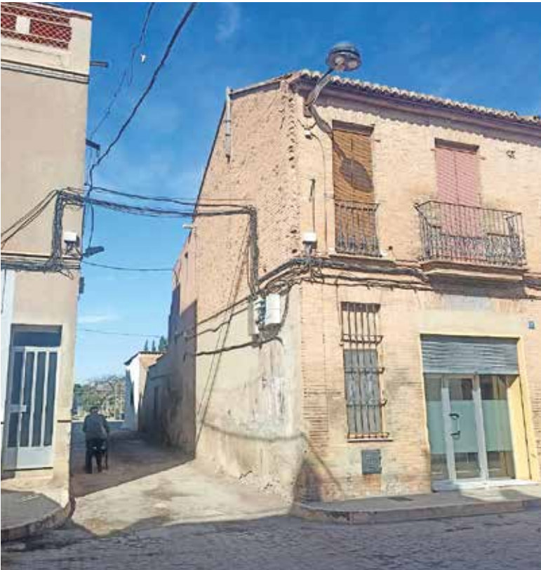
La bomba explotó entre esas dos viviendas
