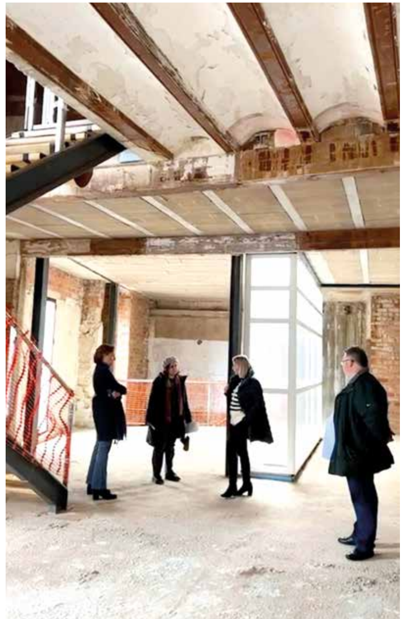
Obres Casa de la Dona
