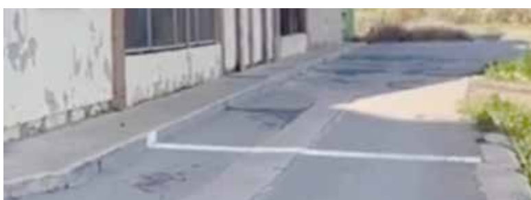
Obres de millora
