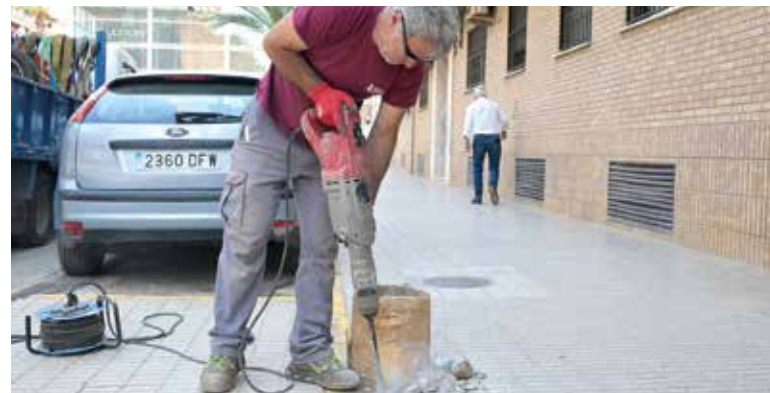
Obres als carrers de Paiporta
