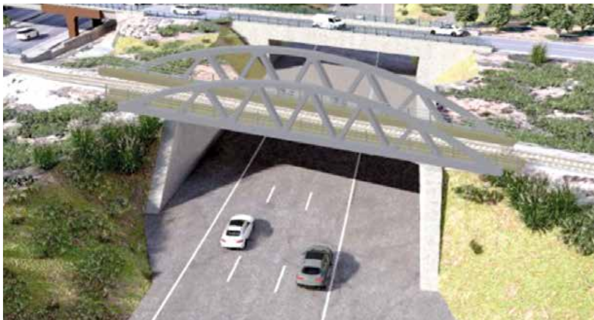
Obres a la A-7
