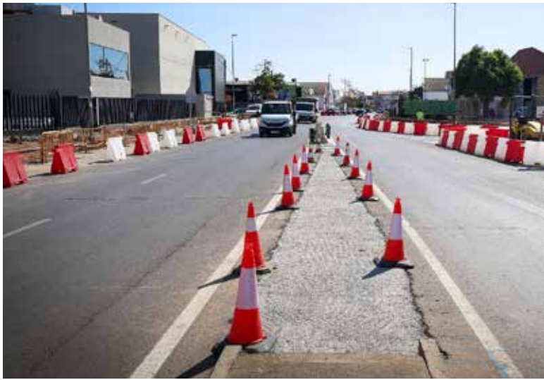
Obres a la zona de Torrent
