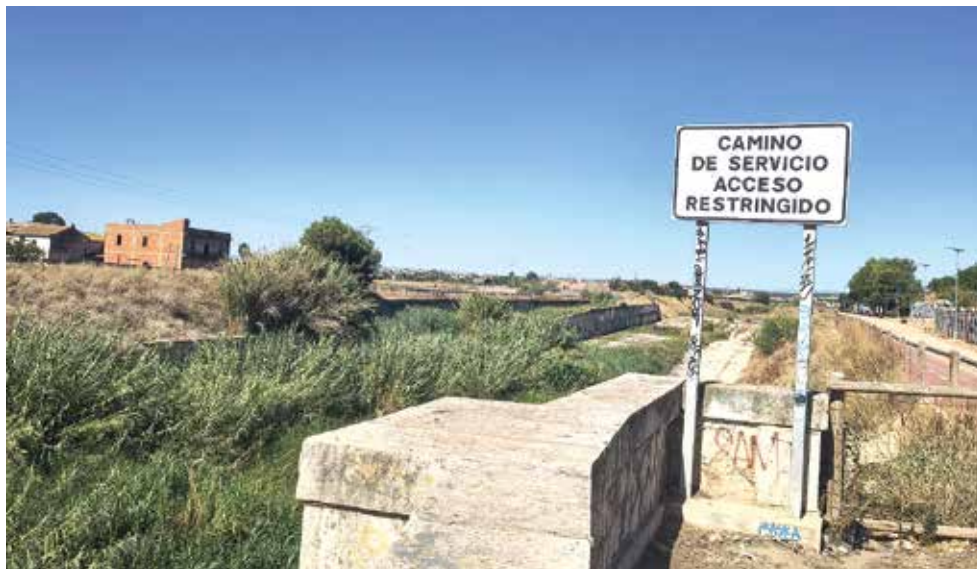
Barranc del Carraixet, accés restringit
