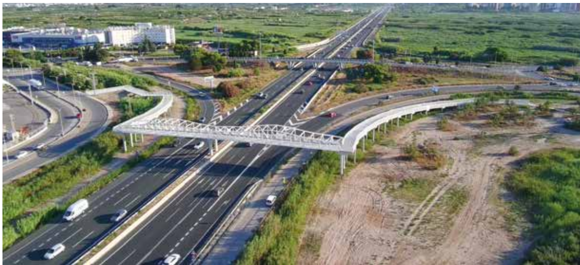
Passarel·la ciclopedestre de Massalfassar
