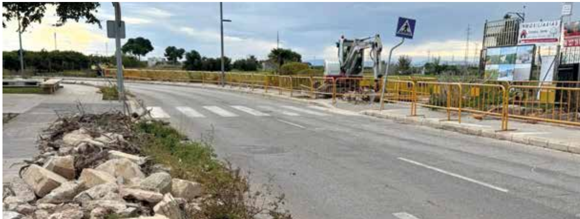
Foios inicia les obres de la ronda
