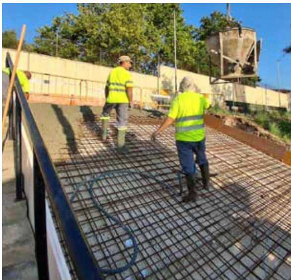
Obres en la via pública
