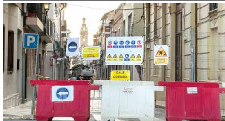
Obres al carrer de Puçol
